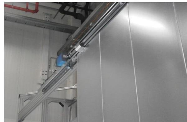
ЕI<sub>2</sub>30, ЕI<sub>2</sub>90, максимальный размер проема 5000x5000
